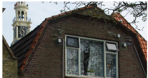
Messtechnik an Hausfassade
