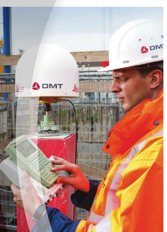
Bauwerksüberwachung mit hochpräzisem GNSS-Equipment.
