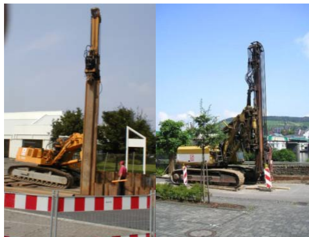
Spundarbeiten in einem Industriegebiet
