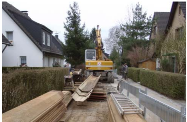
Kanalbaumaßnahme in einem Wohngebiet
