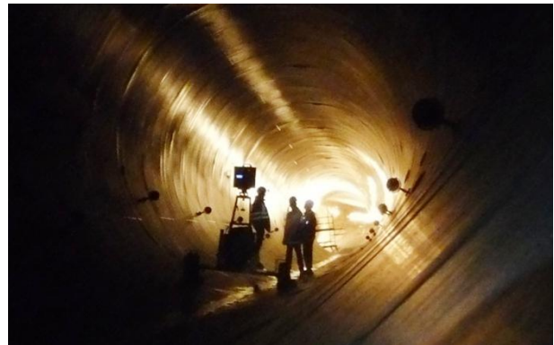
Vermessung in der Druckrohrleitung
