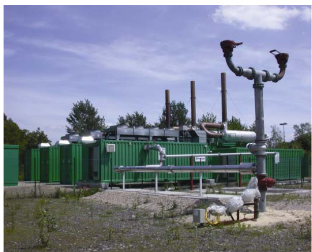
Gasmotoren auf dem Standort eines stillgelegten Bergwerks. Im Ruhrgebiet
