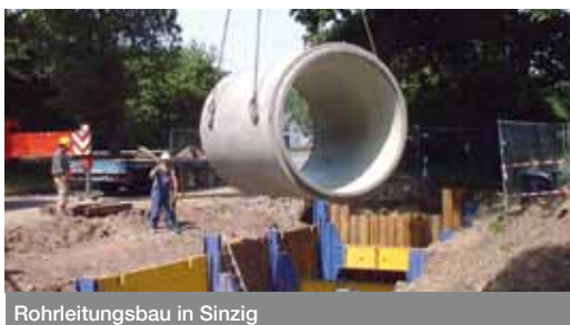
Rohrleitungsbau in Sinzig
