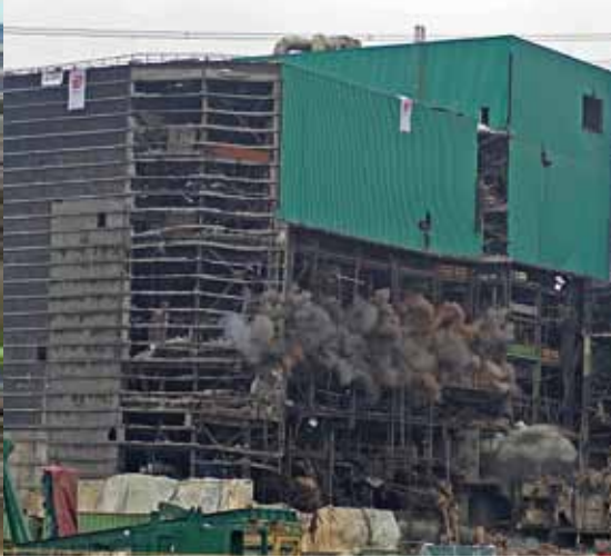
Bild rechts: Rückbau Bergwerk Walsum
