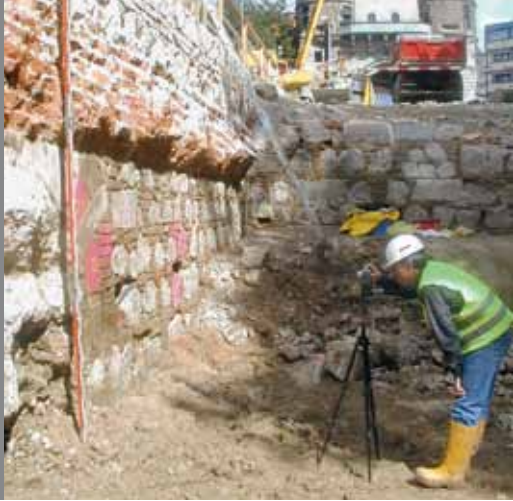
Bild links: Geotechnische Untersuchungen beim U-Bahn-Bau
