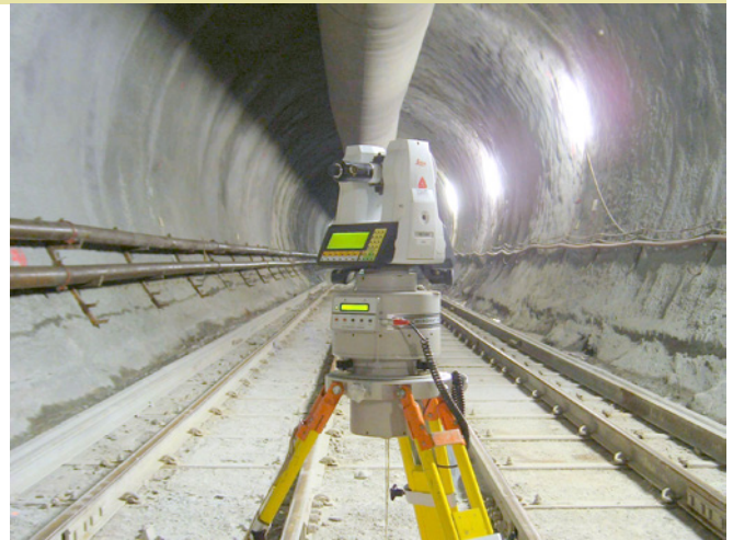
Bild 2: Der Gyromat 2000 im Tunneleinsatz
