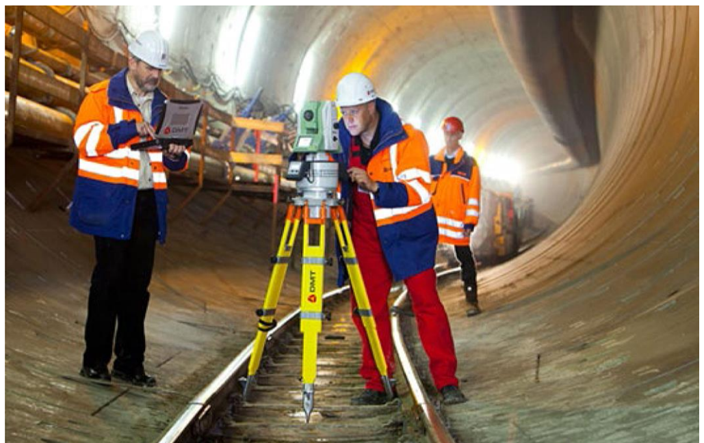
Tunnelvermessung mit GYROMAT 3000
