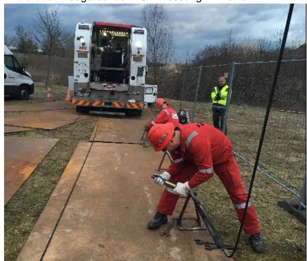
Vorbereitung Geophonkette und Windenwagen in Riem
